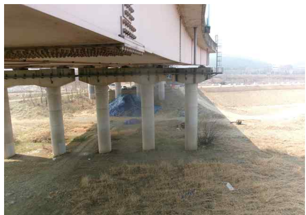
교각 P4 기초 전경
