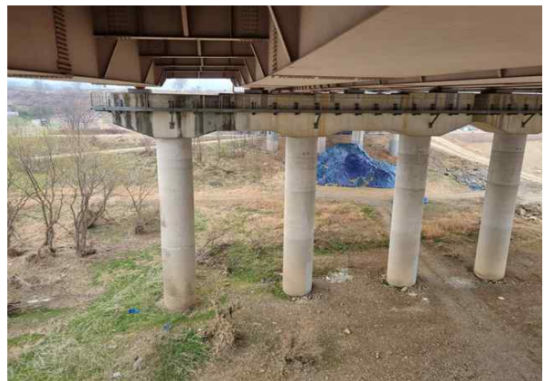
교각 P4 기초 전경
