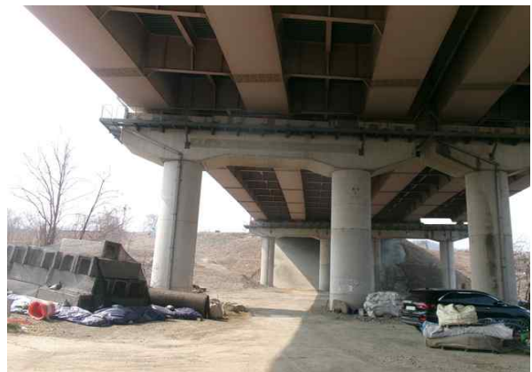
교각 P2 기초 전경
