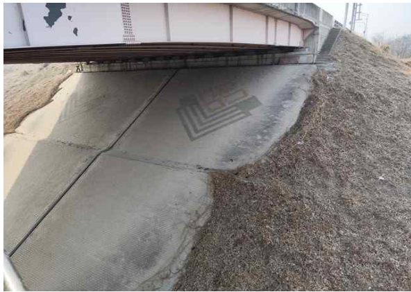
교대 A1 기초 전경
