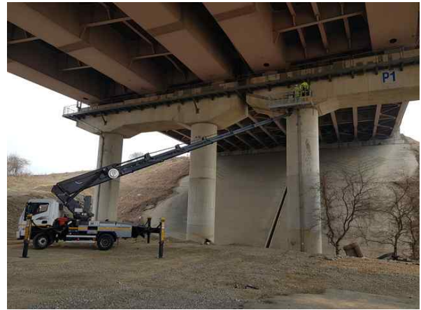
고소작업차를 이용한 근접조사
