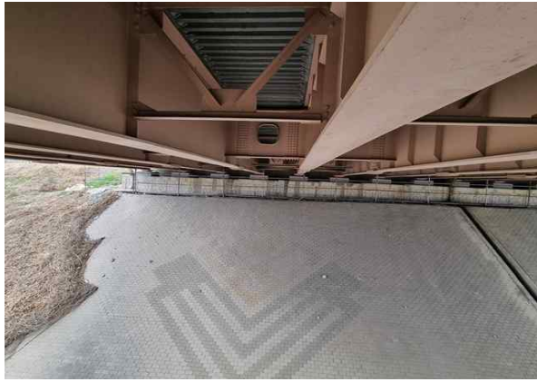
교대 A1 기초 전경
