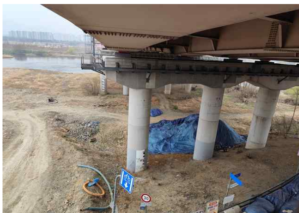
교각 P3 기초 전경
