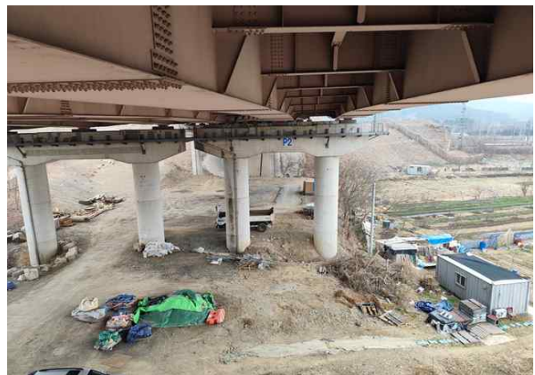
교각 P2 기초 전경
