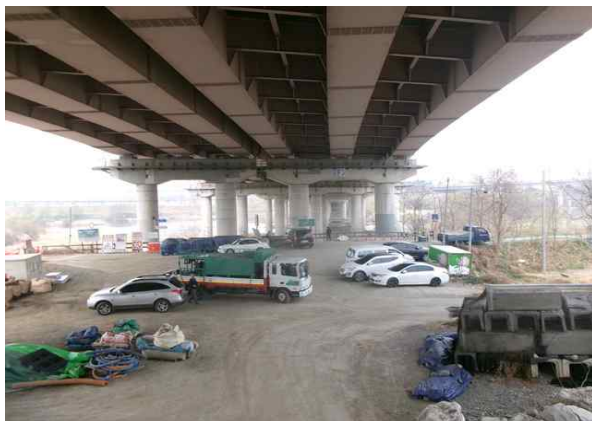
교각 P3 기초 전경
