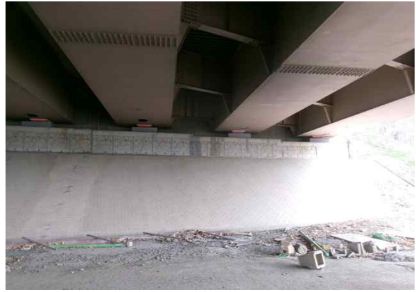
교대 A2 기초 전경
