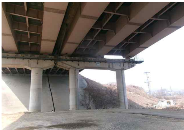
교각 P1 기초 전경
