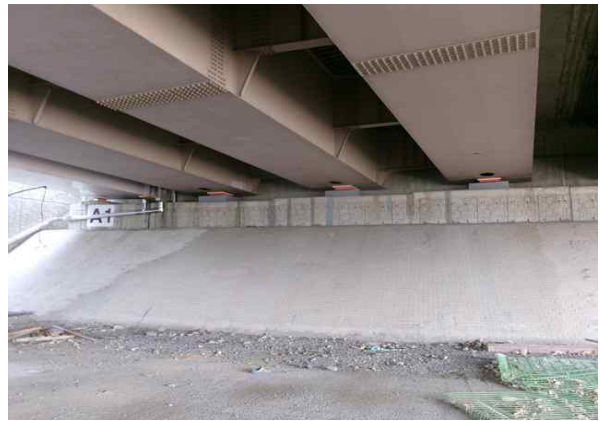
교대 A2 기초 전경
