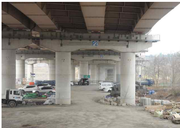
교각 P1 기초 전경
